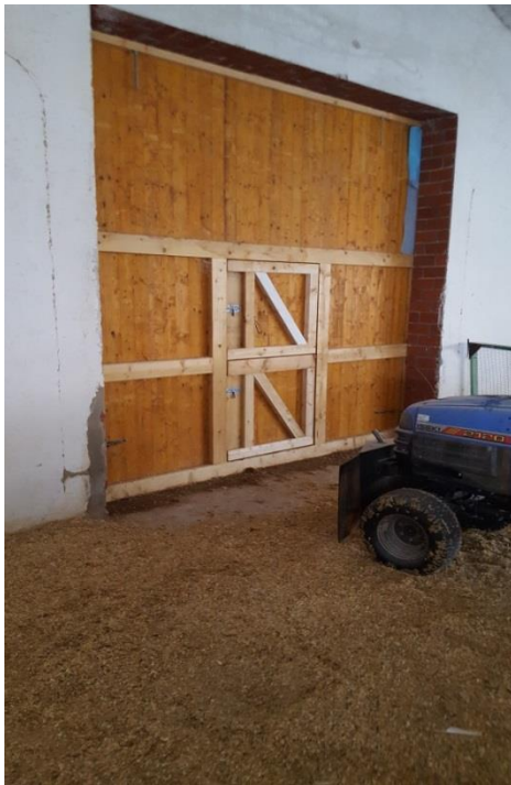
Abbildung 3: „Klöntür“ in einem Putenstall; © Dr. Bröcker, LK CLP
